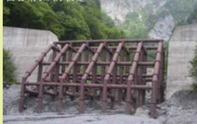
白谷第4砂防堰堤
